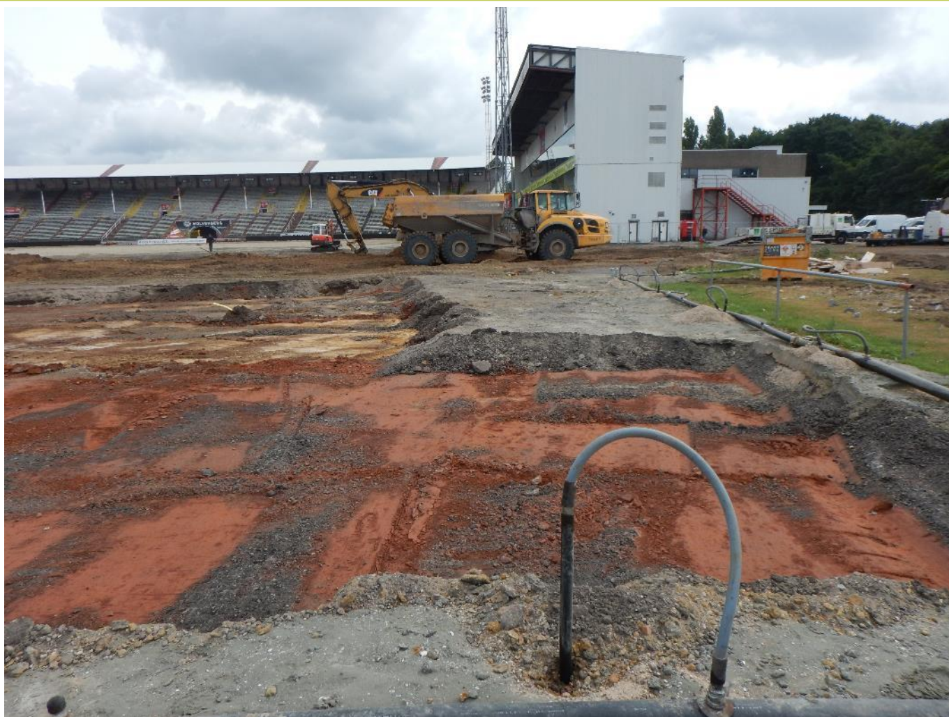
Figuur 28: Foto uitgegraven met steenslag verharde parking bij CB4
