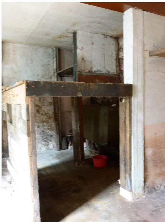
Figuur 6: werkruimten in achterste zone van benedenverdieping huis. Betonpijlers behoren tot het 20 ste eeuwse betonskelet
