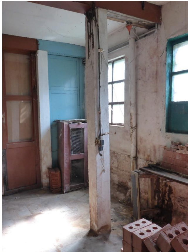
Figuur 5: binnenzicht huidige woning. Betonnen palen behoren tot het 20 ste eeuwse betonskelet
