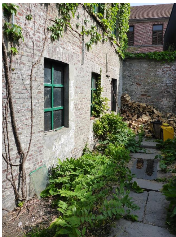
Figuur 7: de bestaande woning vanuit de tuin met verhard pad en achteraan ruïne eenlagig huis. Het opgaand metselwerk is 19 de of vroeg 20 ste eeuwse met typische baksteen en gevelankers
