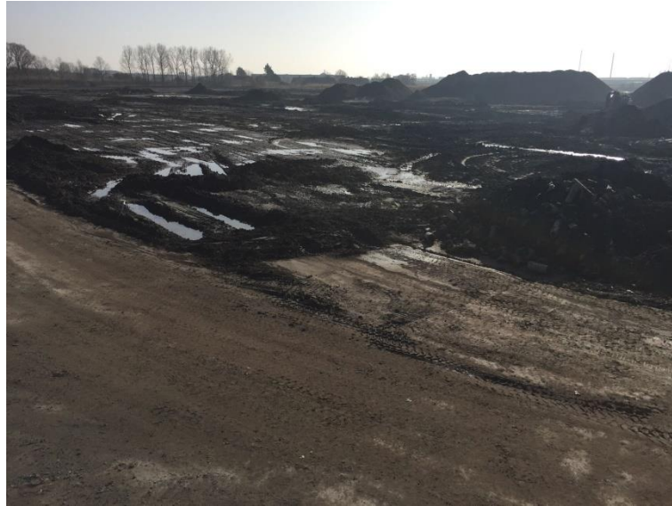
Figuur 7: Foto van het plangebied na het slopen van de fabrieksgebouwen (©ION)
