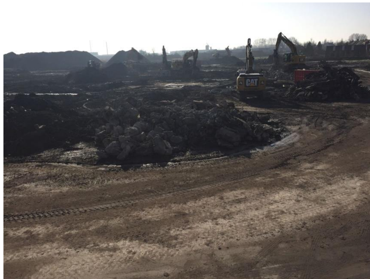
Figuur 6: Foto van het plangebied genomen tijdens de sloopwerken. (©ION)
