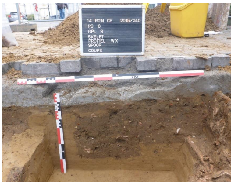
Foto 47: (deel van) oostelijk profiel WX in proefput 8
