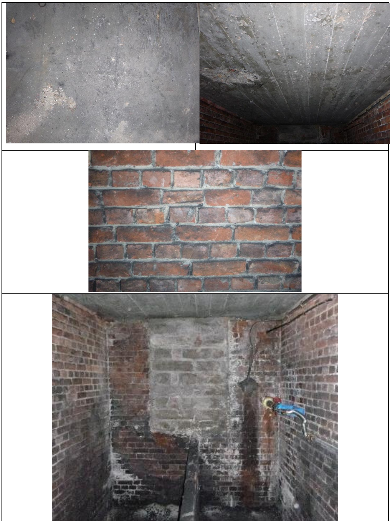
Figuur 11: Foto's van de muren, plafond, vloer, metselwerk en dichtgemaakte venster van kelder 3
