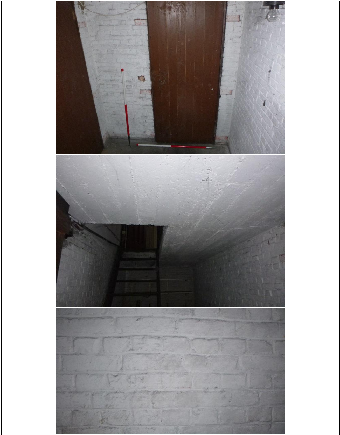
Figuur 9: Foto's van de muren, plafond en metselwerk van kelder 1
