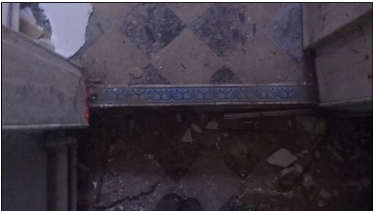
Figuur 26: Overgang hal en gang in woning nummer 39, Sint-Alexiusbegijnhof, Dendermonde.
