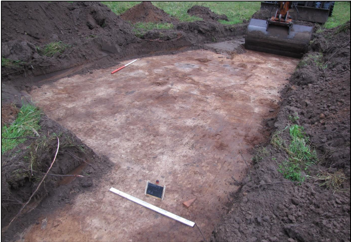
Figuur 34 Aanleg van een kijkvenster in de noordelijke hoek van sleuf 2.
