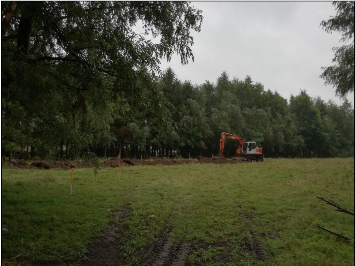
Figuur 29 Zicht op de aanleg van sleuf 1 in het zuidoostelijke deel (bron: initiatiefnemer).
