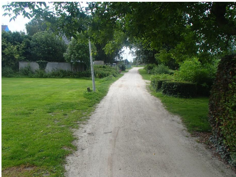
Figuur 17: Terreinsituatie van het fietspad met dolomiet verharding
