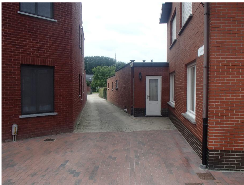
Figuur 16: Terreinsituatie bekeken vanaf de Tienpondstraat
