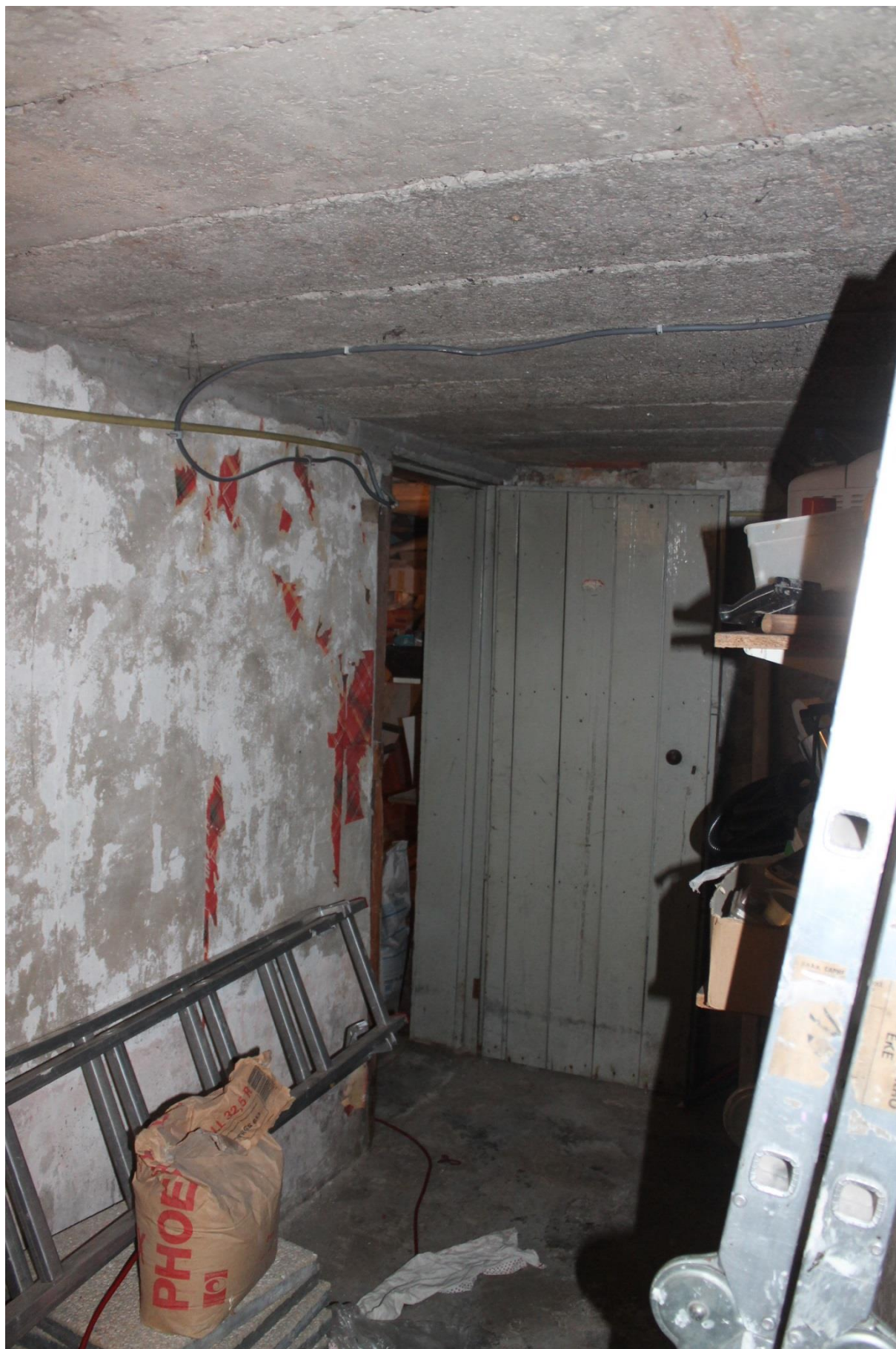
Figuur 41: Noordwand ruimte 1
