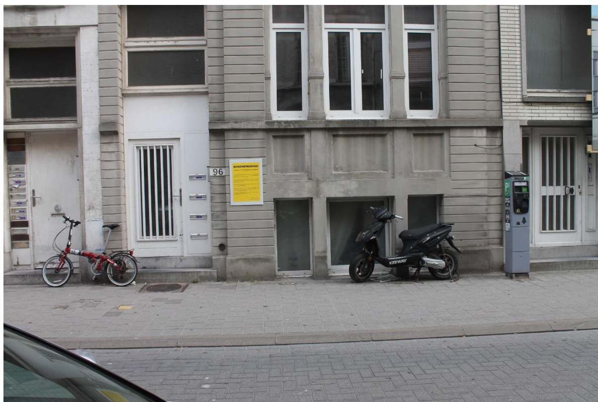
Figuur 49: Raamopeningen half verzonken kelderruimtes , nr. 96
