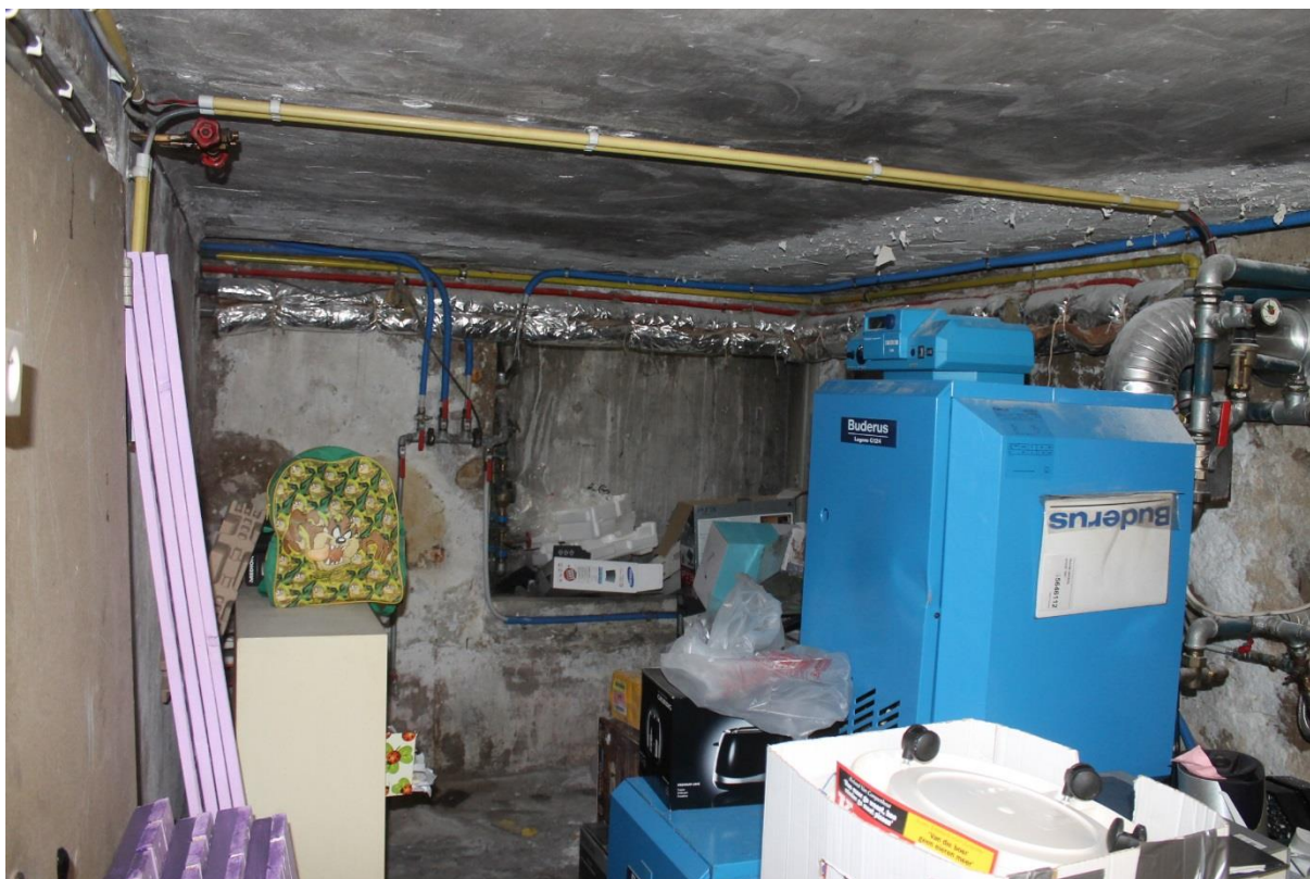
Figuur 44: Zuidwand ruimte 3 met kolengat
