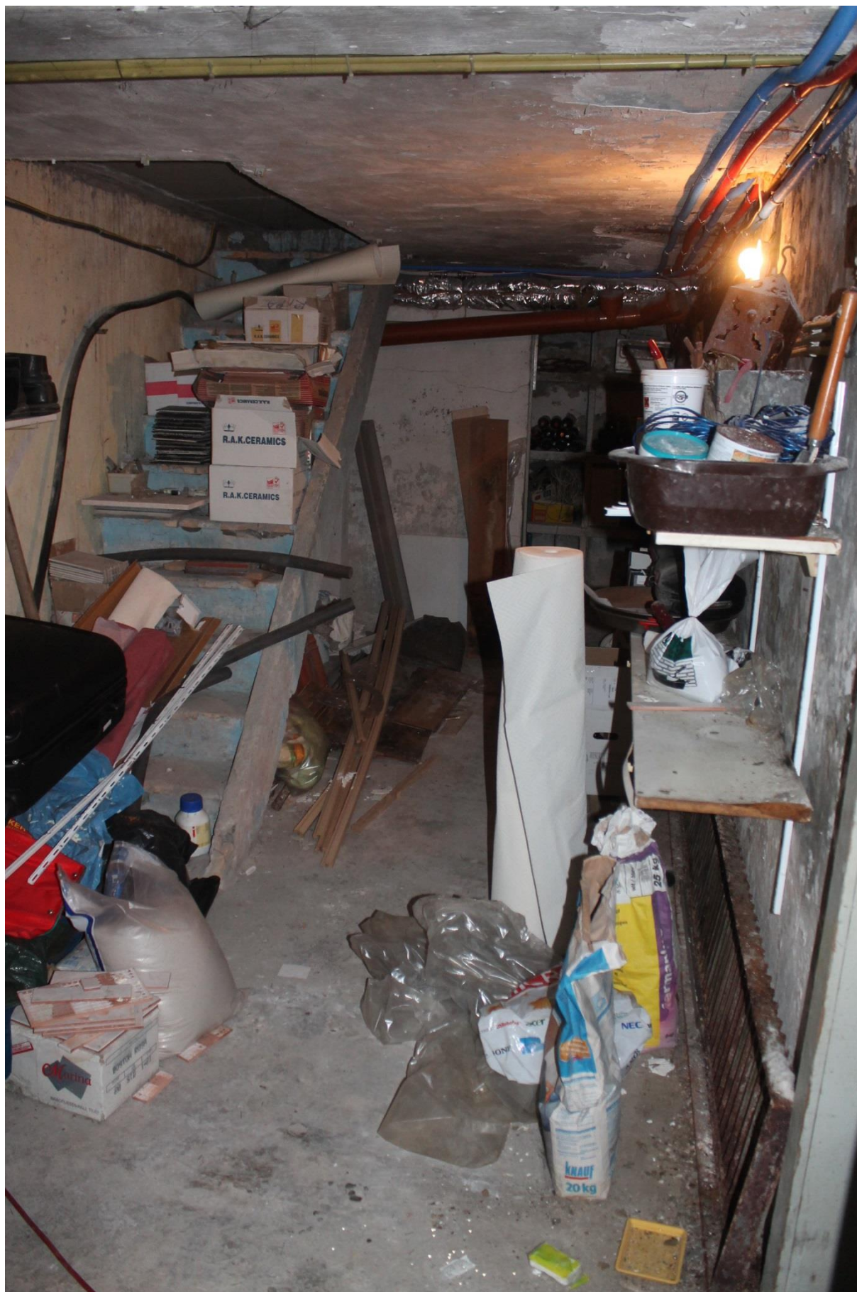
Figuur 43: Noordwand ruimte 2
