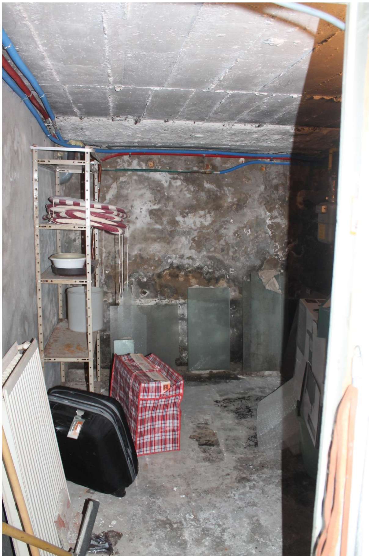
Figuur 42: Zuidwand ruimte 2
