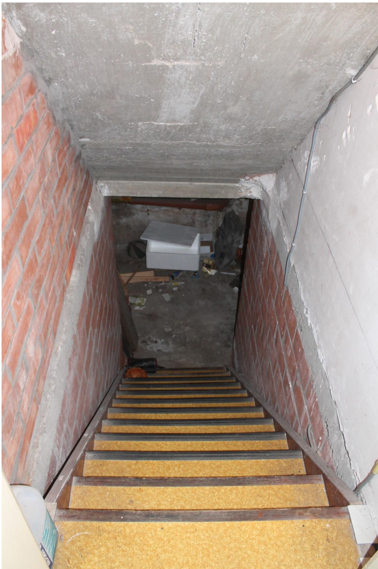
Figuur 40: Keldergat met trap die toegang bied tot ruimte 1
