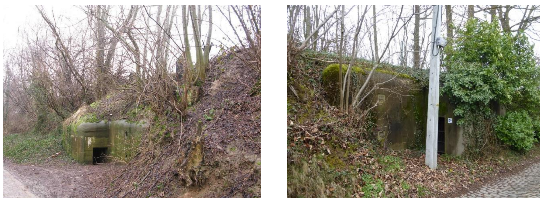
Figuur 19: voorbeeld bunker KW-linie (IOE 2017)
