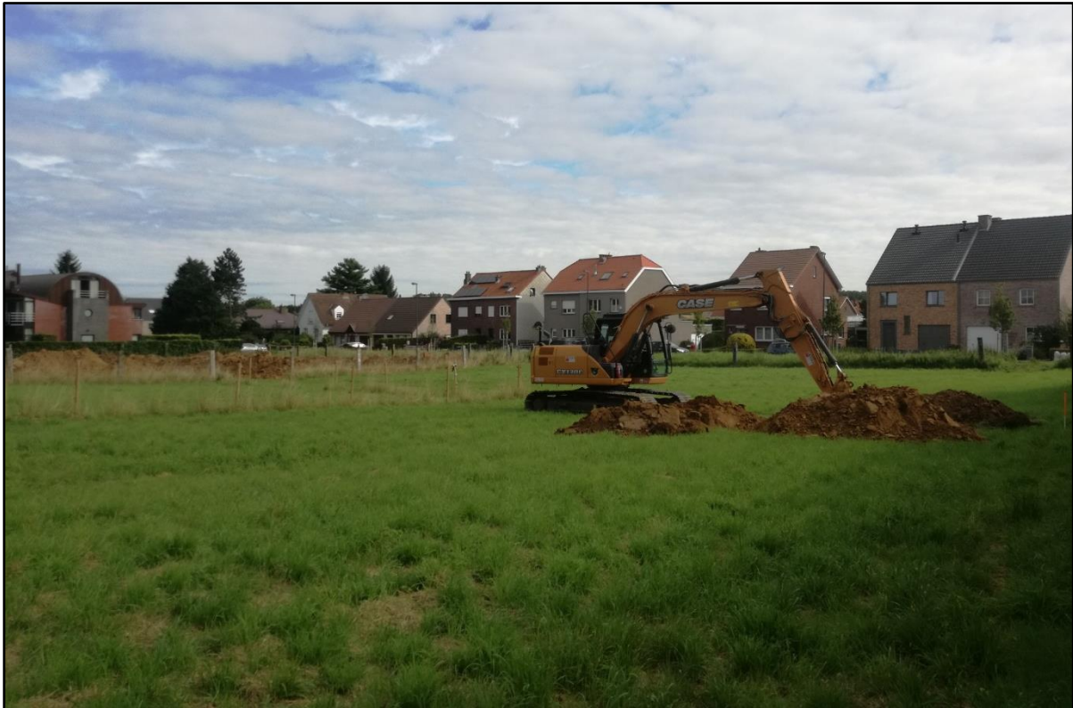
Figuur 4 Overzichtsfoto tijdens de aanleg van de sleuven.
