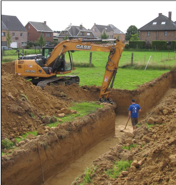
Figuur 6 Aanleg van kijkvenster 2 in sleuf 1.
