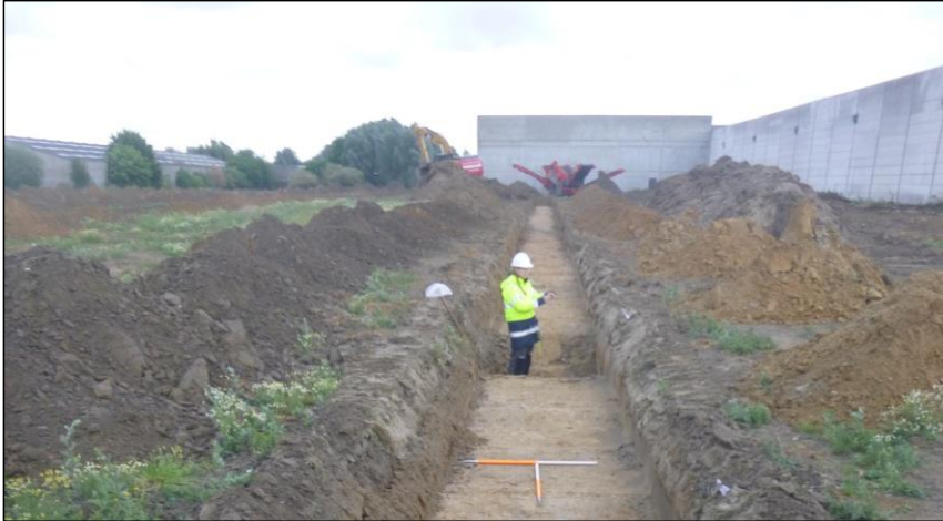
Figuur 36: Werkput 5 met achteraan zicht op de nog bestaande hal die in de nieuwbouw geïncorporeerd gaat worden.
