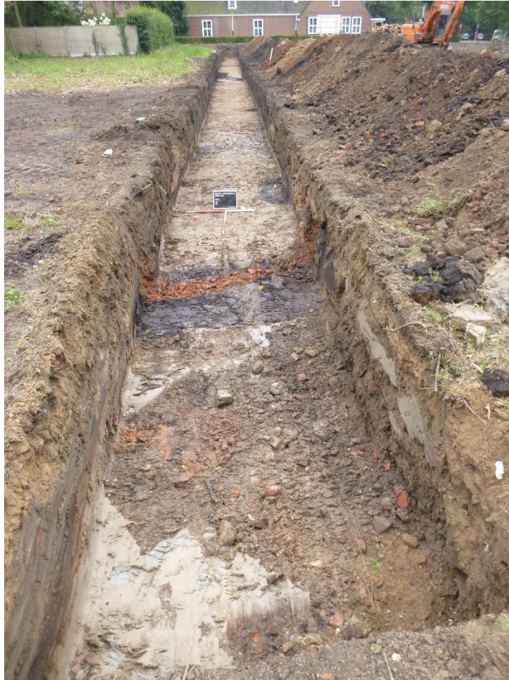
Figuur 30: Zicht op uitbraakkuil en verstoring aan de noordelijke zijde van WP3 (Abo nv)
