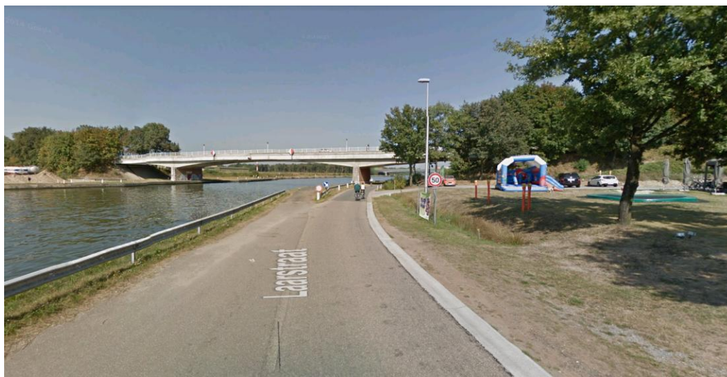
Afb. 6. Gezicht op het plangebied vanuit het zuidoosten [bron: Google Maps, streetview]
