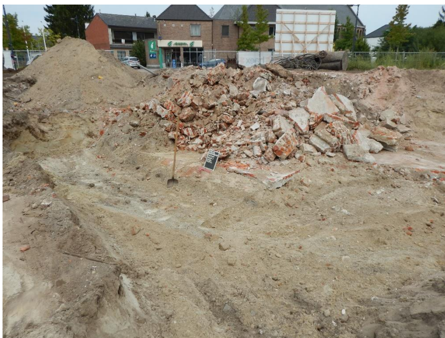
Fig. 20: de bouwput van de uitgebroken kelder
