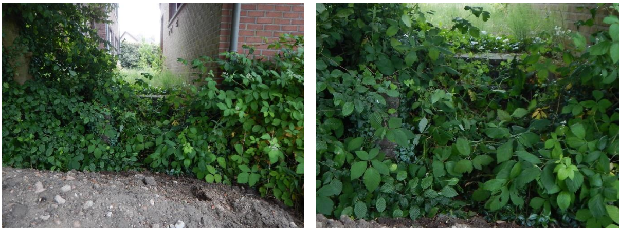
Fig. 5: de scheidingsmuur tussen de twee terreinhelften en het trapje van de ene helft naar de andere.
