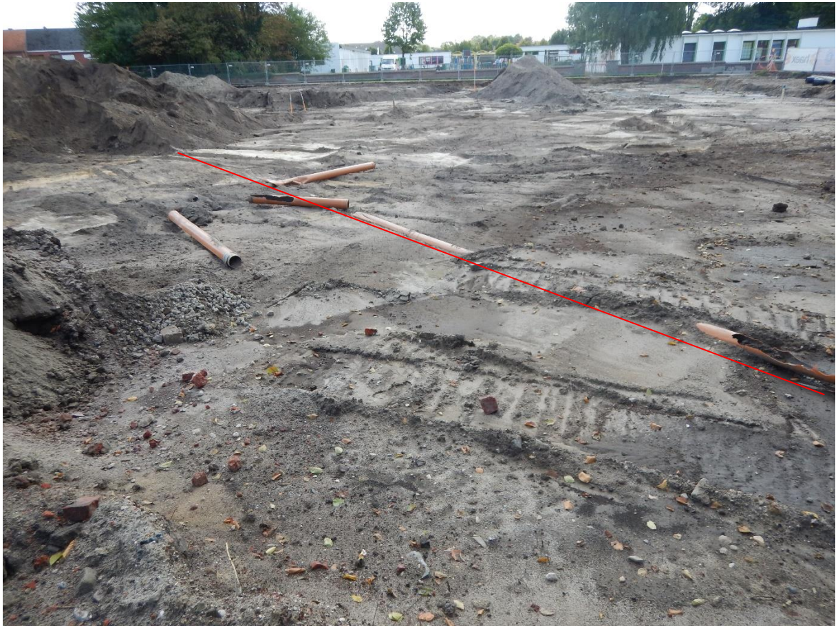
Fig. 10: één van de twee afvoerbuizen na gedeeltelijke afgraving van heel het terrein, foto dd 01/09/2017 © Haast bvba
