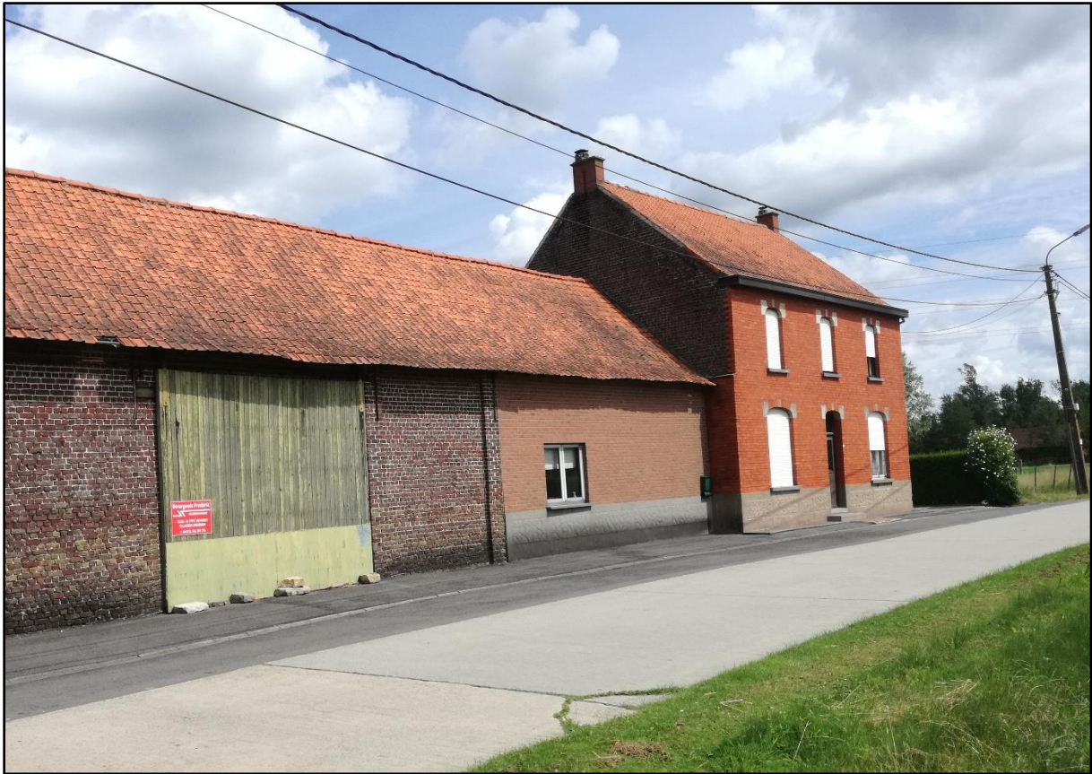
Figuur 4 De bestaande bebouwing aan de straatkant, gezien vanuit het zuiden. Het deel rechts van de groene poort wordt niet afgebroken, de rest wel.
