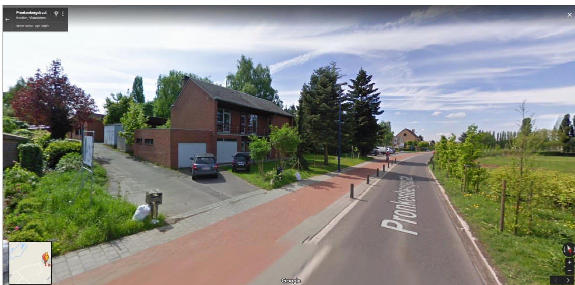
Figuur 4: Woonhuis aan de Pronkenbergstraat (Google Street View, april 2009)
