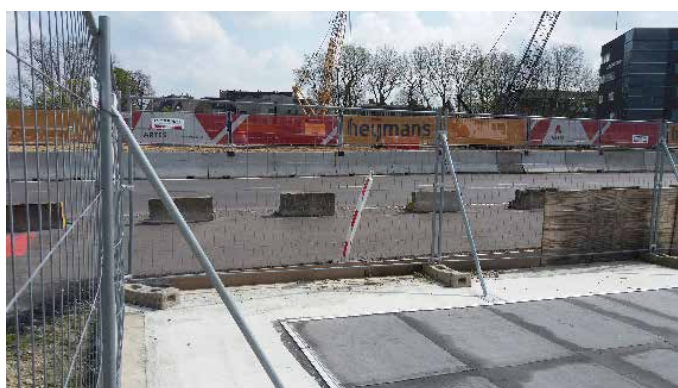
Figuur 19: De huidige toestand op de site ter hoogte van de inrit van de ondergrondse parking (© SBE)
