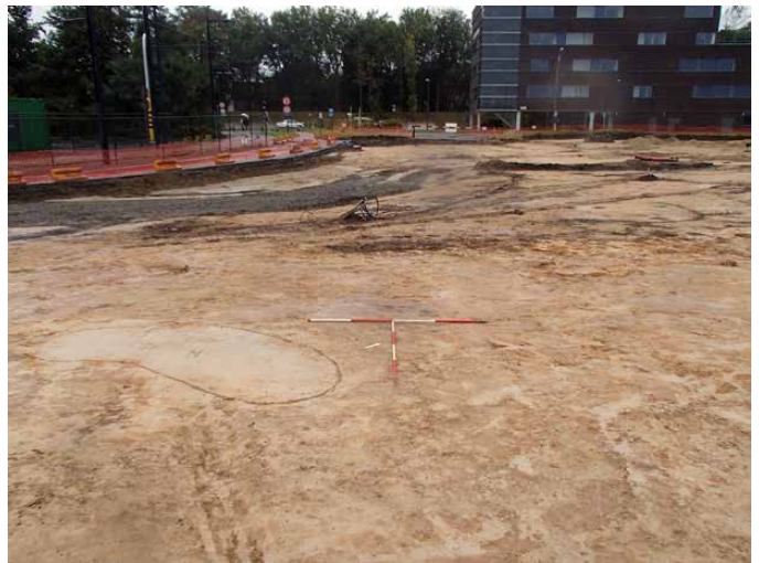
Figuur 39: Ter hoogte van de uitrit van de ondergrondse parking komen enkel recente verstoringen voor
