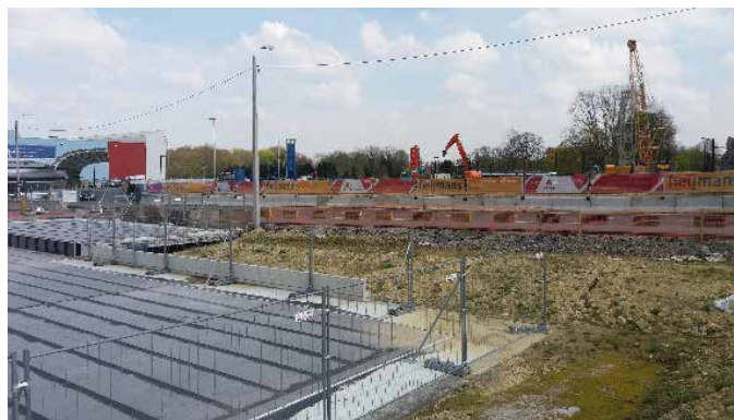
Figuur 18: De huidige toestand op de site ter hoogte van de inrit van de ondergrondse parking (© SBE)
