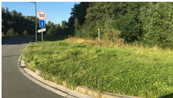
Figuur 17: De opgehoogde grasstrook waar het fietspad zal worden aangelegd (© De Logi & Hoorne)
