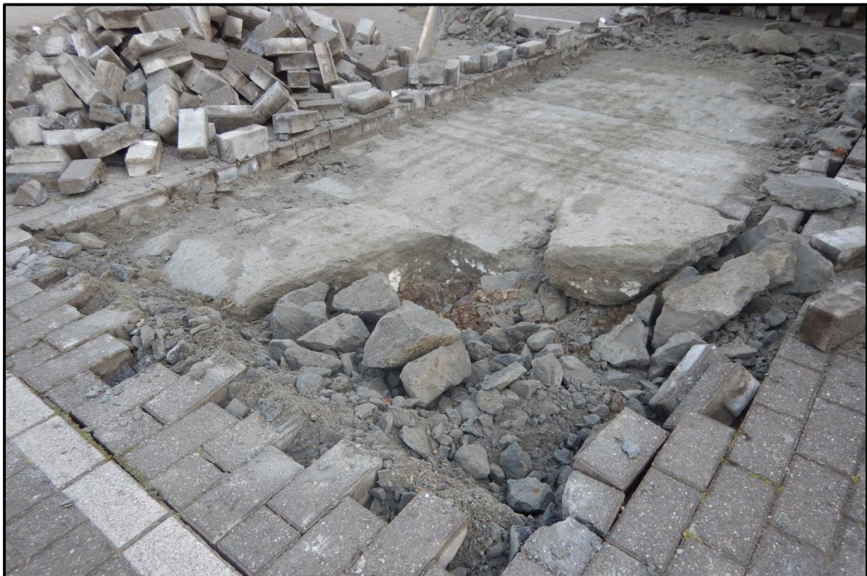
Figuur 4: Zicht op het beton onder de verharding.
