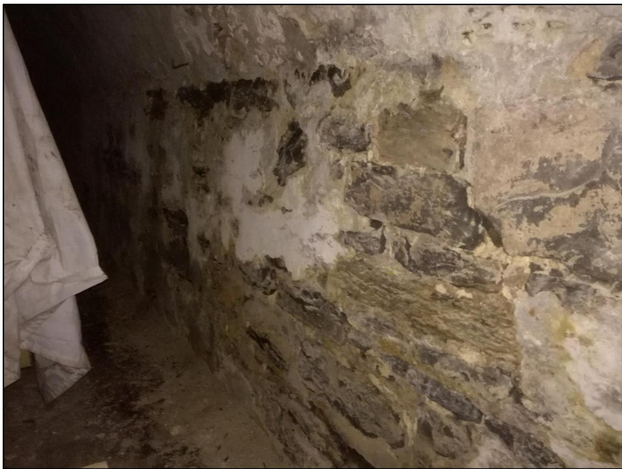
Figuur 19 Keldermuur in Doornikse kalksteen, in de achterste kelder van Markt 24.
