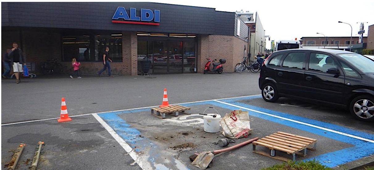
Foto 3: Zicht op de ingang van het winkelpand met in de voorgrond parking, ter hoogte van boring 2, gezien vanuit het westen. (©BAAC)
