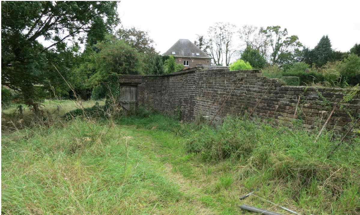
Figuur 16: Muur centraal in het plangebied (foto richting zuiden)
