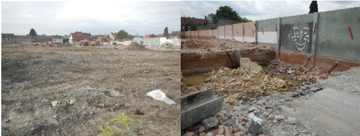
Figuur 2: Omstandigheden na de sloopwerken en tijdens de 2 de fase van het veldwerk.
