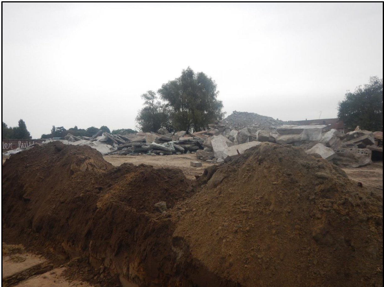
Foto 1: Zicht op opgehoopt puin vanuit het westen op een reeds gesleufde zone.
