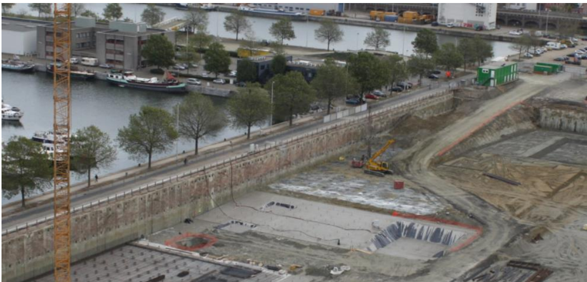
Figuur 11: Aanleg ondergrondse parkeergarage (bron: Bouwen aan ZNA 2017).
