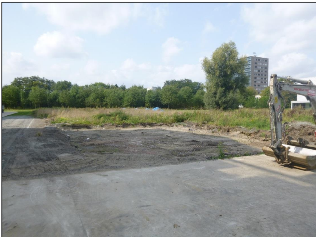
Figuur 33: Toestand van het zuidelijke deel van het terrein voorafgaand het proefsleuvenonderzoek, gezien vanuit het oosten
