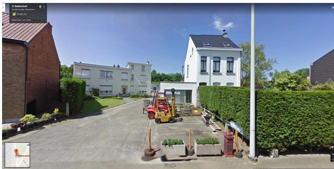
Figuur 5: De nog aanwezige gebouwen die gesloopt dienen te worden (Google Street View, 2017)
