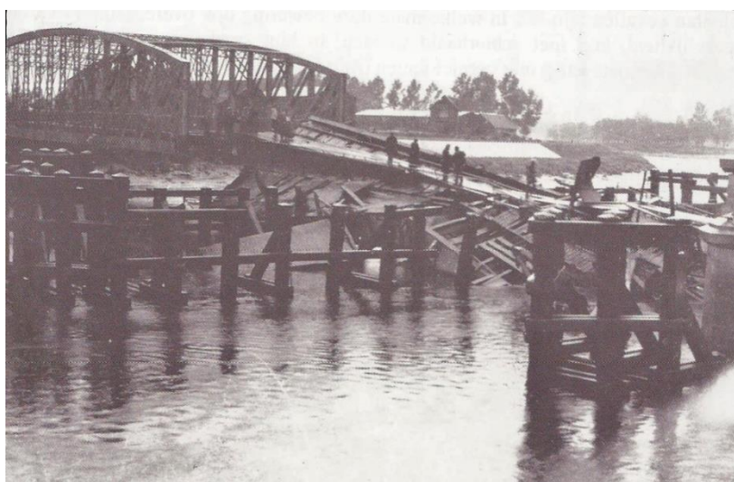
Figuur 26: De voormalige Scheldebrug (Bron: https://willyvandamme.files.wordpress.com/2014/09/dendermonde-scheldebrug-vernieling-gezien-vanuit-veerstra.jpg , 2017).
