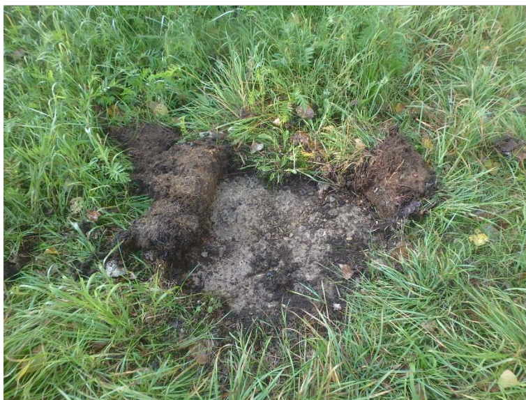
Figuur 45: Beton ter hoogte van boring 5 (Archebo bvba, 2017)
