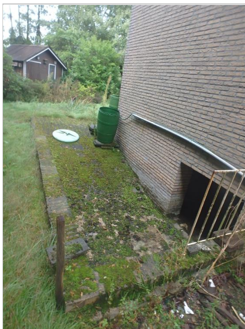
Figuur 12: Talud naar de kruipkelder (Archebo bvba, 2017)
