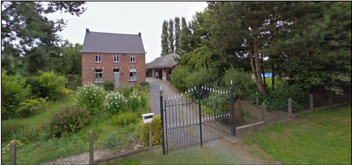
Figuur 2 Zicht op de bestaande woning en stalling ter hoogte van Bokslaarstraat nr. 36 (bron: google maps).
