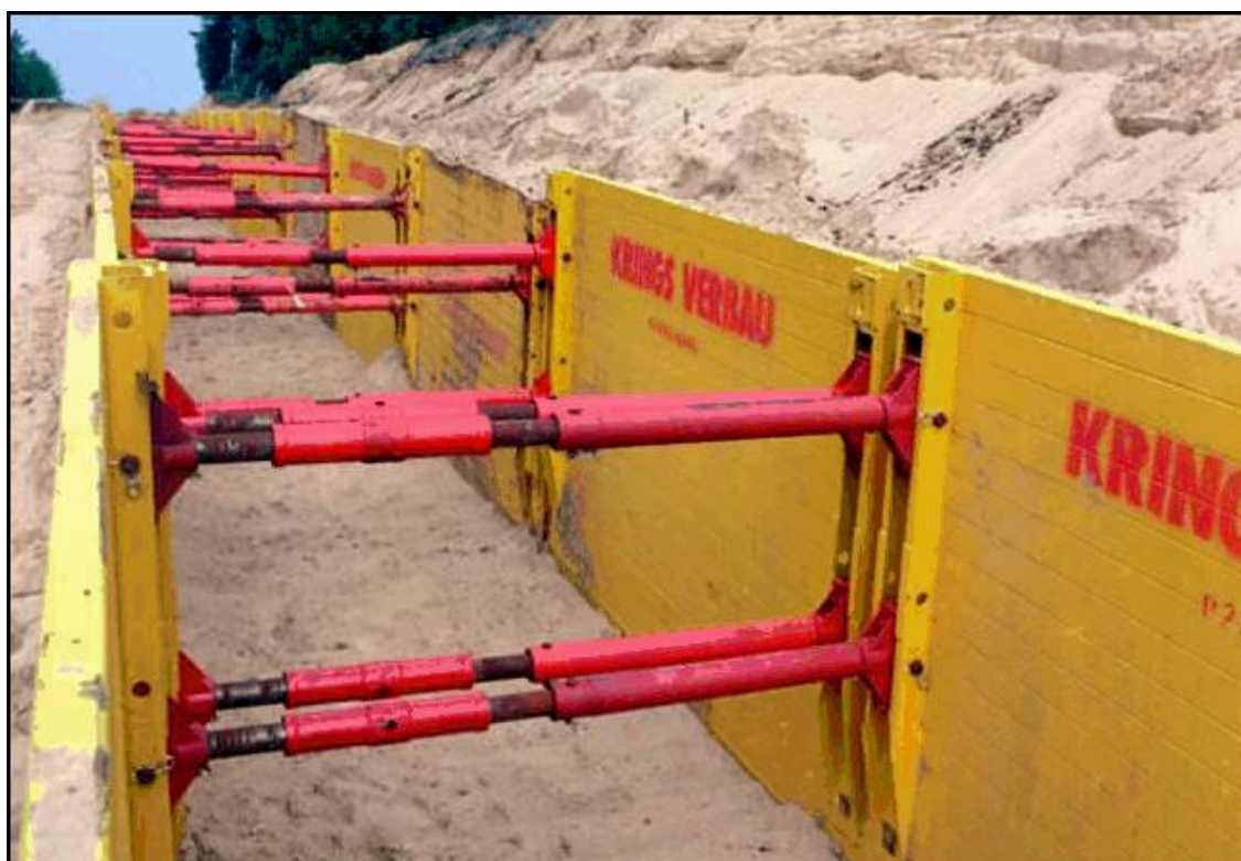
Afbeelding 1: Typevoorbeeld van kringbeschoeiing.
