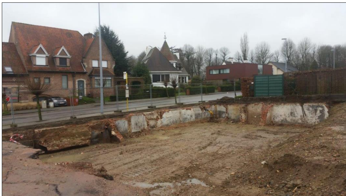
Figuur 23: Onderkeldering aan de Felix D'Hoopstraat.
