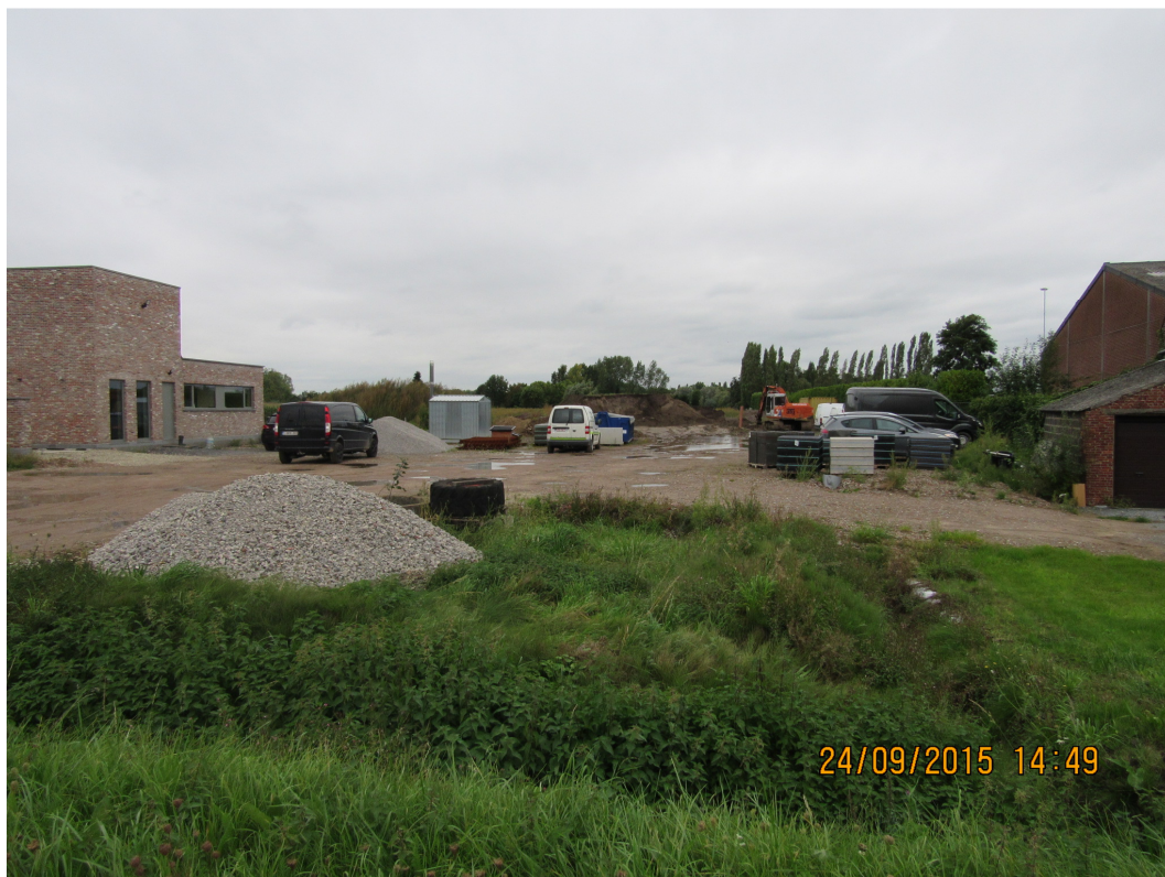
Afb. 5. Foto van de huidige situatie op het terrein. 3
