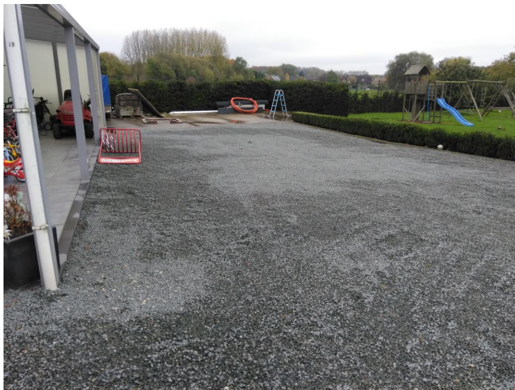
Figuur 9. Overzichtfoto's terreinbezoek ADEDE, bovenaan zicht op achterzijde huisnummer 13, onderaan locatie nutsleidingen en hemelwaterputten
