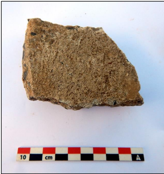
Figuur 15: Foto van de betonbrok (vnr. 9).
