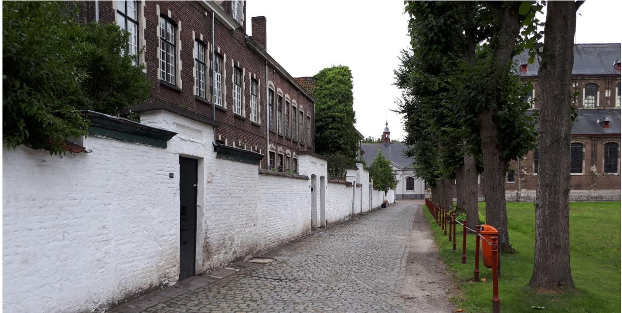
Figuur 4: zicht op de bestaande verharding ten oosten van binnenplein. Hier is geen riolering of waterafvoer aanwezig
