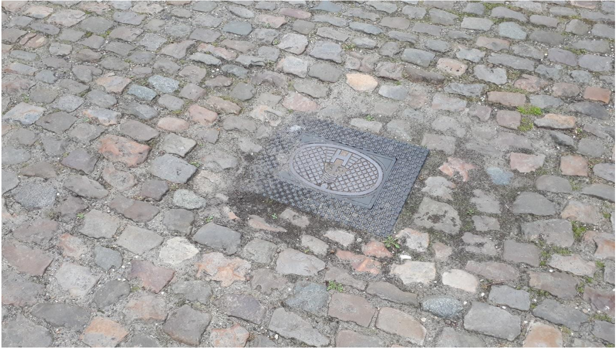
Figuur 6: bestaande verharding met wateraansluiting centraal in weglichaam
