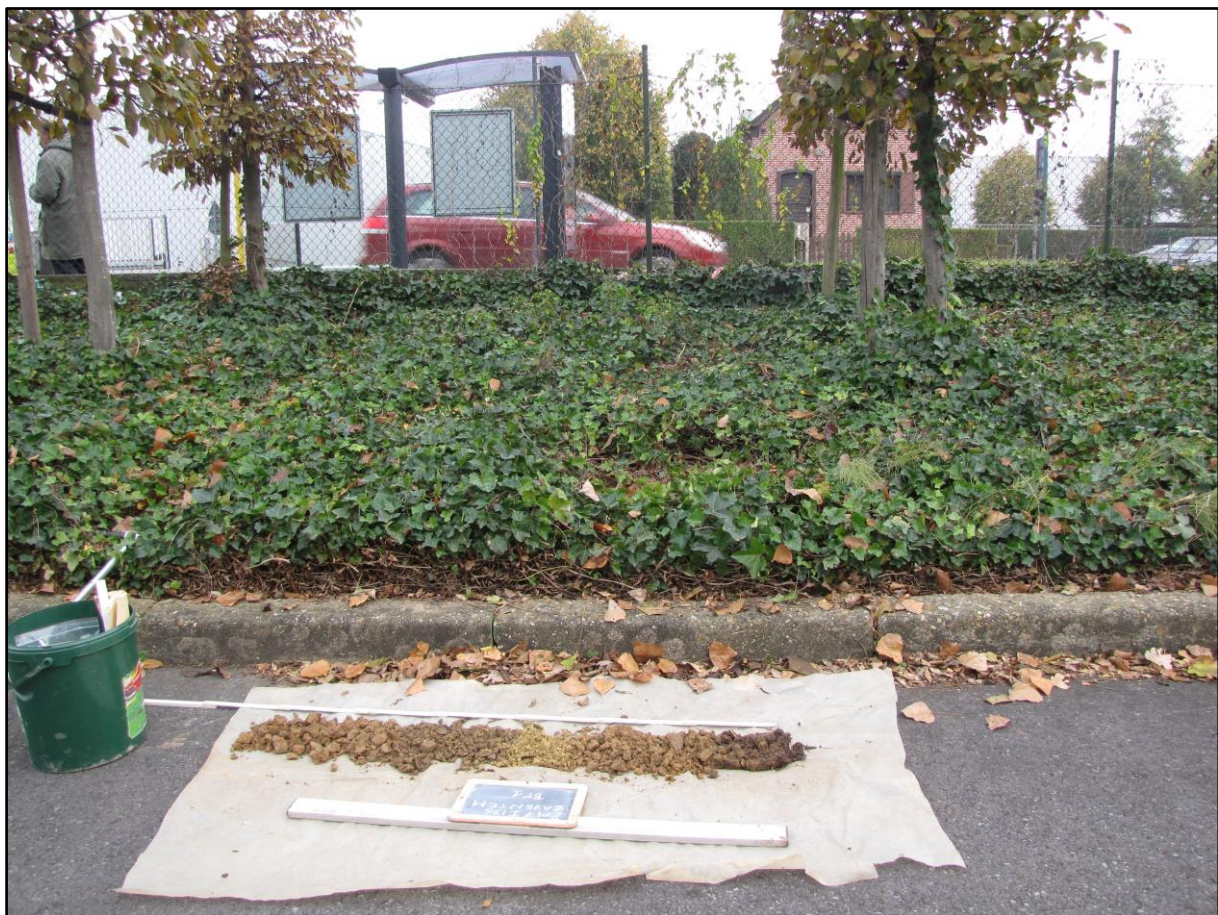
Figuur 27 Zicht op de locatie van boorpunt 1 ter hoogte van de steile helling.
