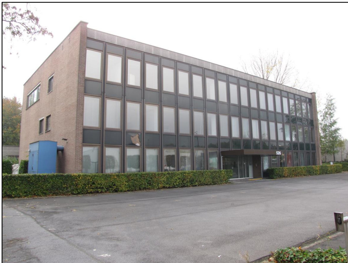
Figuur 7 Zicht op het voorste kantoorgebouw met drie verdiepingen en een kruipkelder.
