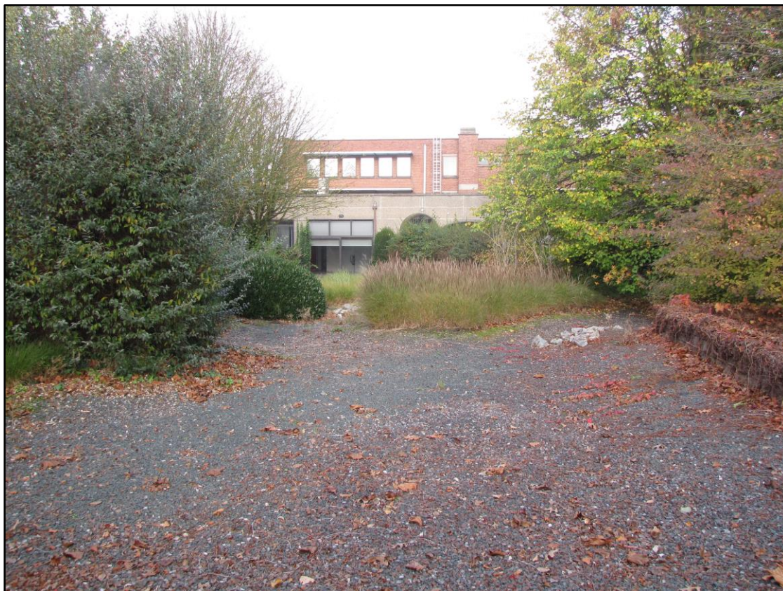
Figuur 14 Centraal diep uitgegraven kiezelpad met de lager gelegen kantoorgebouwen.
