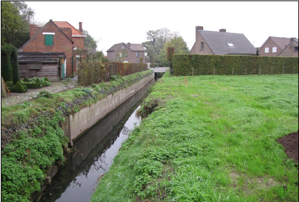
Figuur 1 Zicht op de Ede in oostelijke richting met de wandverstevingen in beton en steen.
