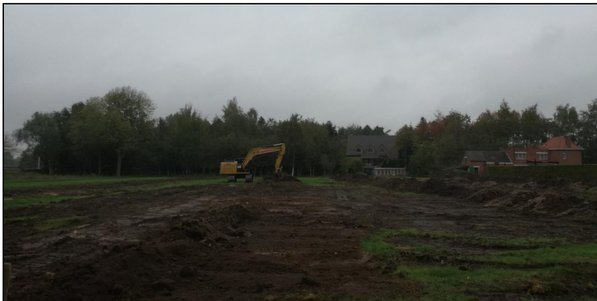
Figuur 12 Machinaal dichtten van de proefsleuven.
