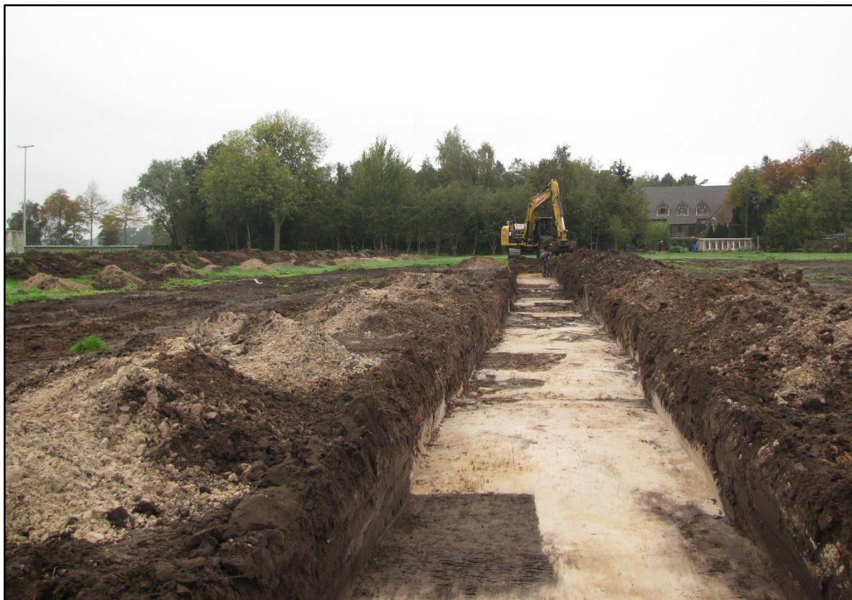
Figuur 6 Overzichtsfoto tijdens de aanleg van de sleuven.
