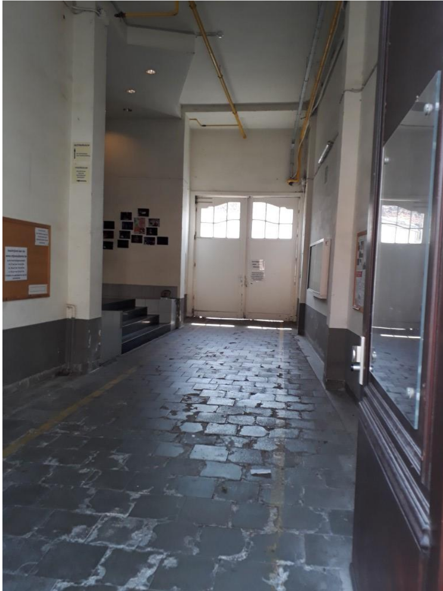
Figuur 5: Bestaande toestand, zicht op onderdoorgang
