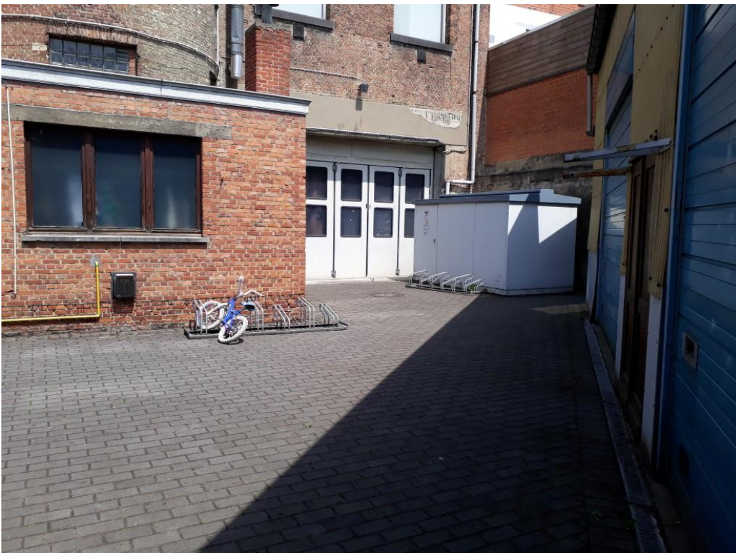
Figuur 7: Bestaande toestand, zicht op koer
