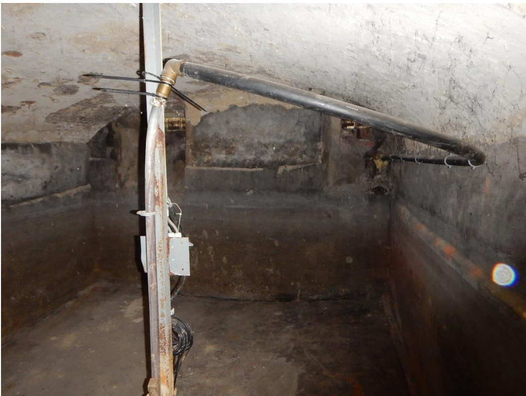
Figuur 11: Zicht op de kelder
