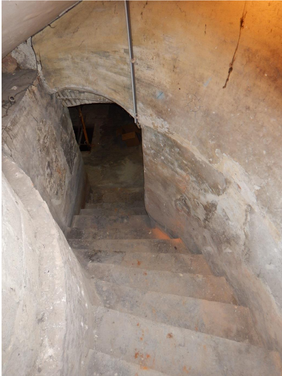
Figuur 12: Toegangstrap naar de kelder
