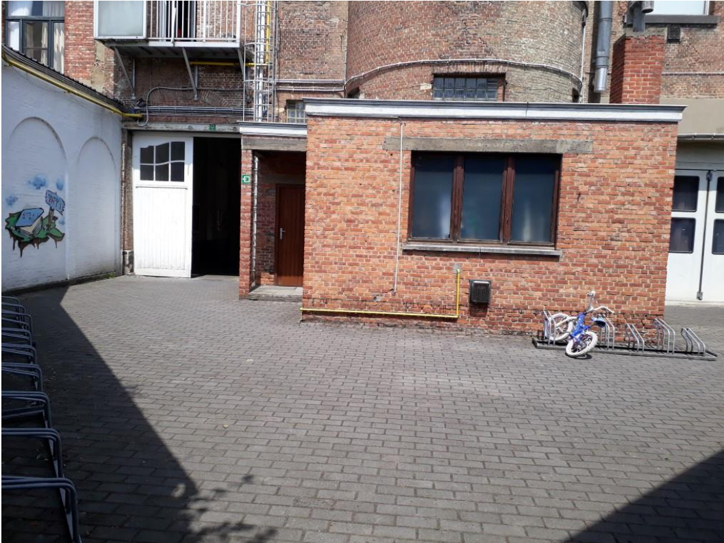
Figuur 6: Bestaande toestand, zicht op koer
