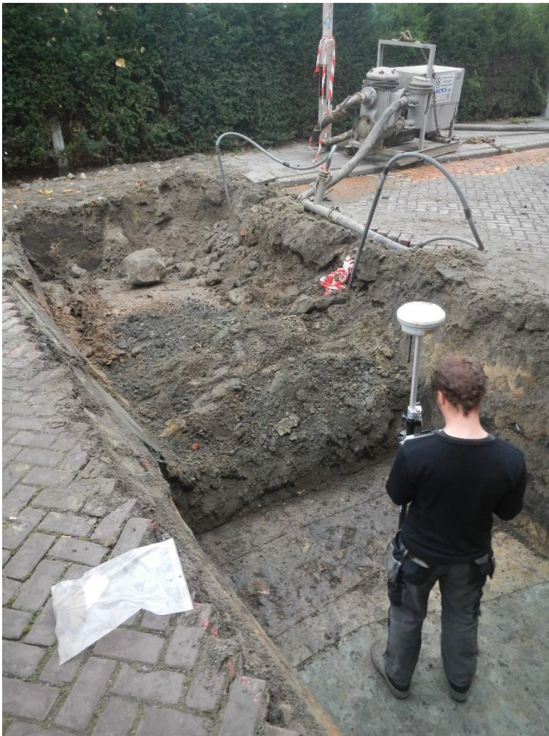
Figuur 6: Beeld van het door leidingen verstoorde deel binnen werkput 2
