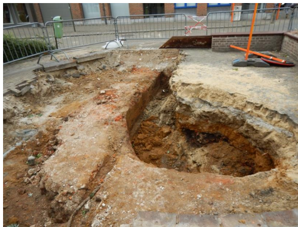
Afb. 6: de vrijgegraven fundering van de Verwerstoren in mei 2017
