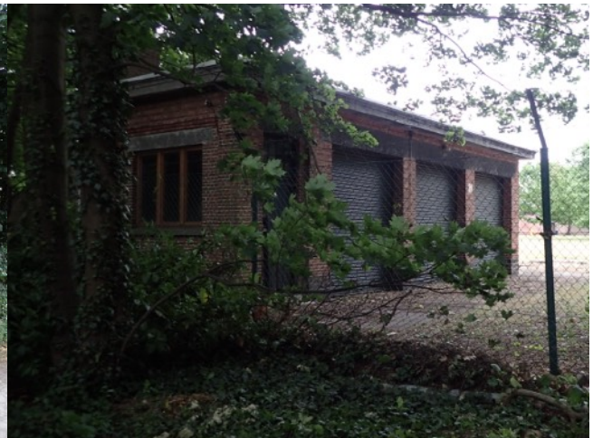
Het noordelijk af te breken gebouw.
