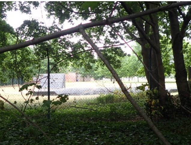
Zicht op de bunker ten noorden van het af te breken gebouw
