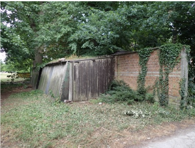
De constructie ten noorden van het te behouden gebouw.
