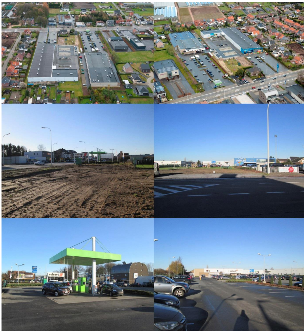
Figuur 3: Bestaande toestand
