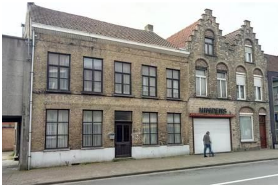
Figuur 7: Links onderdoorgang naast huis nr 55 (ID 16776) dat is vastgesteld als bouwkundig erfgoed. 8
