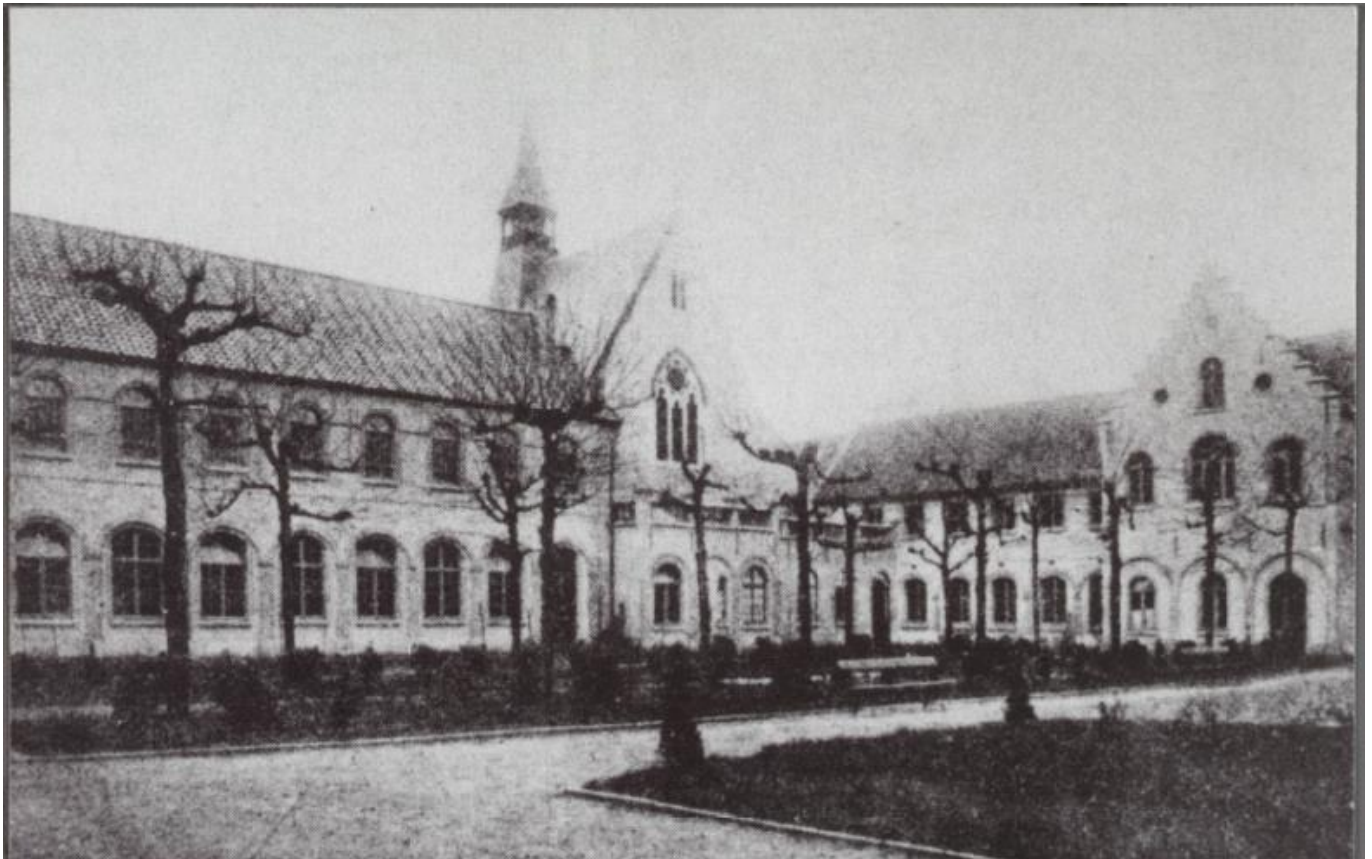
Figuur 39: zicht op het instituut van Sint-Juliaans van de tuin af gezien. Centraal is de kapel waarneembaar, 1924. (Bron: Erfgoed Brugge)
