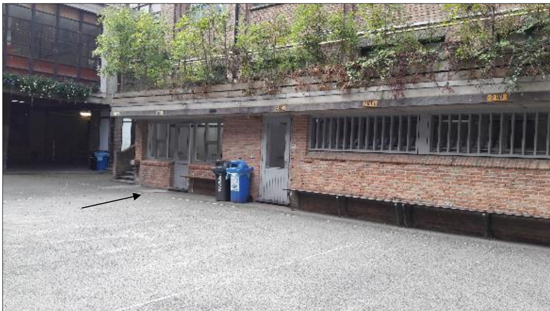
Figuur 51. Lokalisatie beerput 2 ter hoogte van de kleine speelplaats
