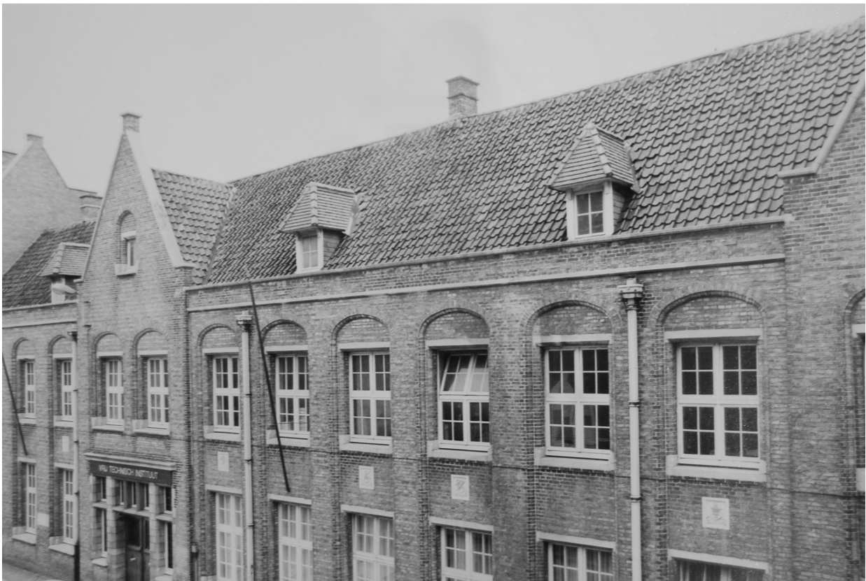
Afb.: Foto's van de toestand voor de dakvernieuwing. (Bron: Stadsarchief Brugge, bouwdoosiernr. 1977/951)
