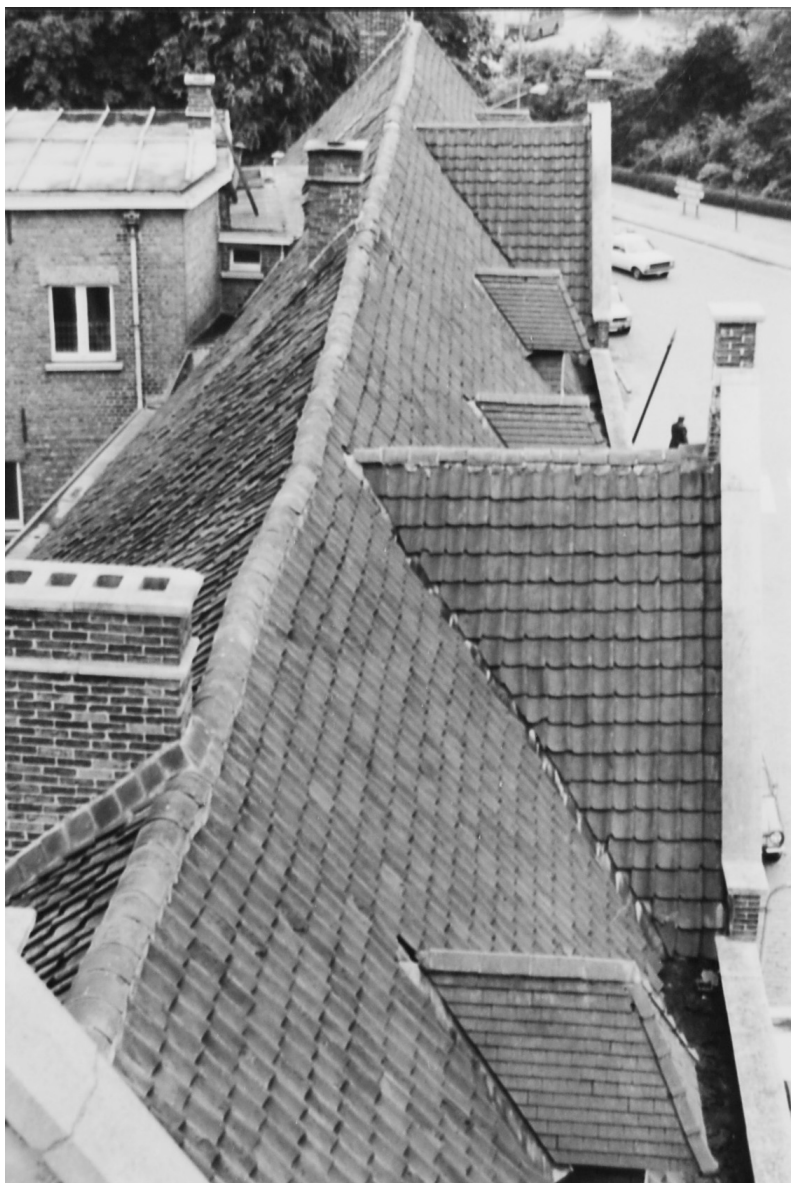
Afb.: Foto van de toestand voor de dakvernieuwing. (Bron: Stadsarchief Brugge, bouwdoosiernr. 1977/951)
