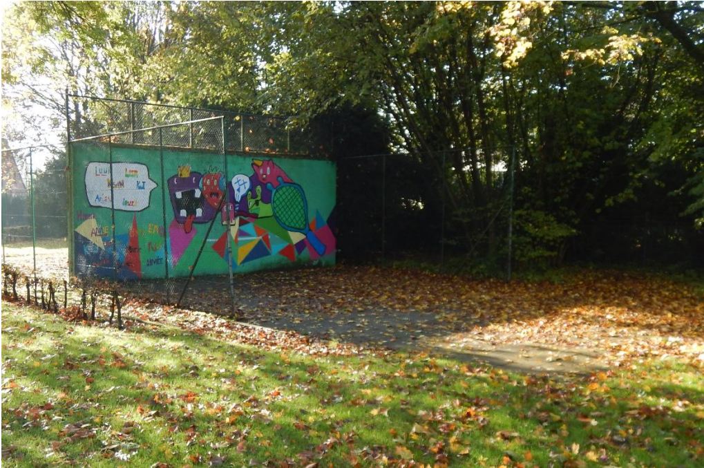
Fig. 18: de verharding voor één van de “tennismuren” die zal opgebroken worden en vervangen door teelaarde met er doorheen de aanleg van een wandelpad in ternairmengsel.
