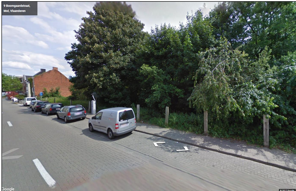
Fig. 29: zicht op het terrein vanuit de Boomgaardstraat met op de achtergrond, rode blinde bakstenen zijgevel, het huis dat aan de Boomgaardstraat stond op perceel F718L © google streetview
