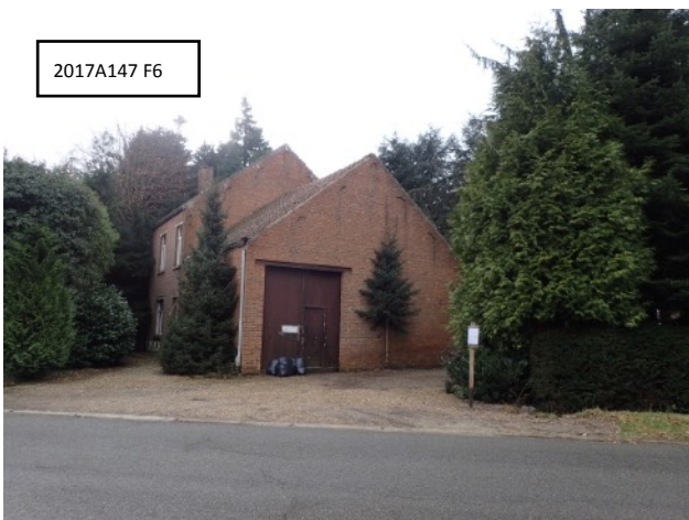
De woning aan de noordelijke grens, zijde Zavelstraat.
