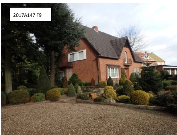
De woning aan de zuidoostelijke grens, zijde Oudstrijdersstraat.
