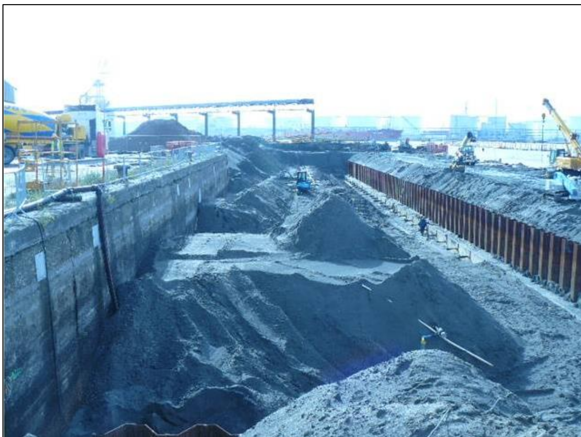
Figuur 7: Foto's van de opvulling van het Graandok in 2012. (Bron: ATO 2017)
