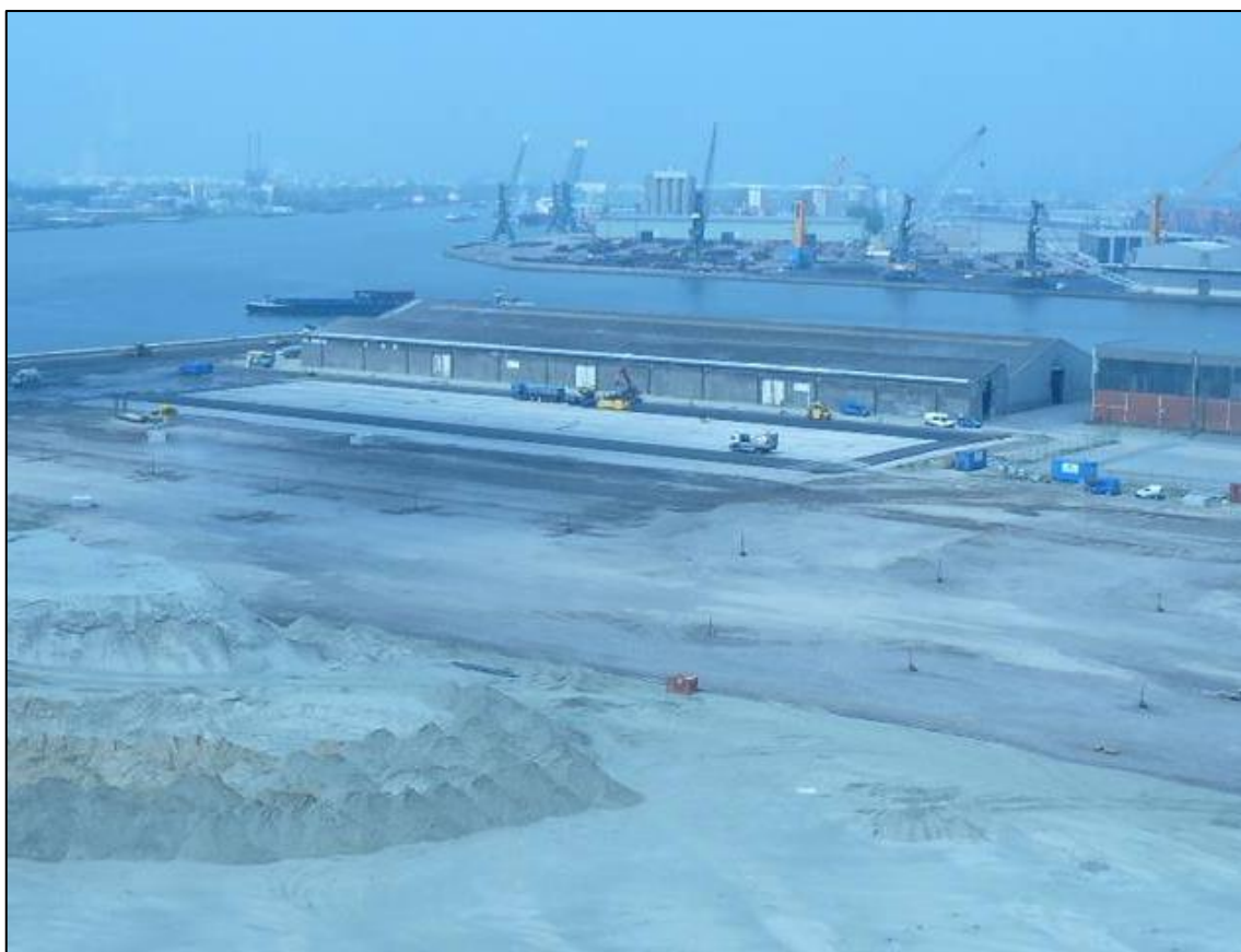
Figuur 8: Foto van de laatste fase van de demping van het Graandok. (Bron: ATO 2017)
