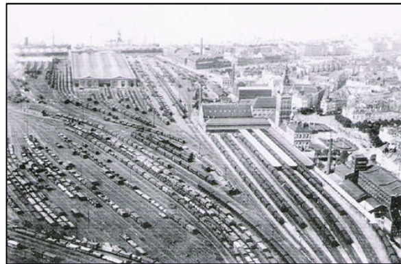
Figuur 20: Zicht op de achterterreinen van het Zuidstation 19
